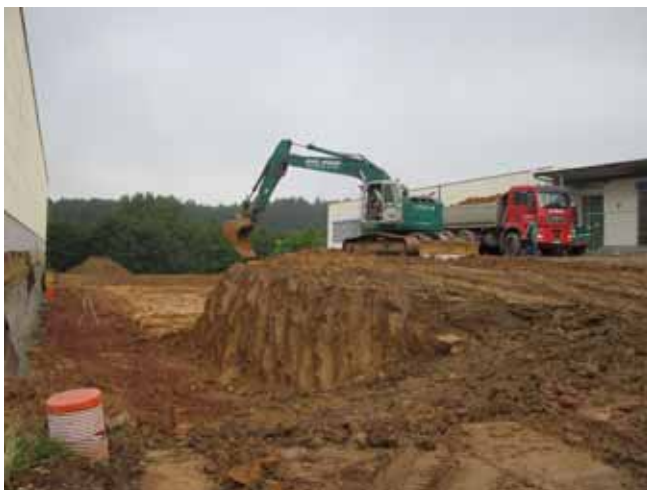
Sicht von der Straßenseite
